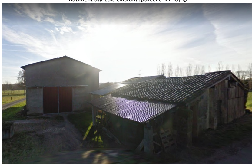
Bâtiment agricole existant (parcelle D 248) ↓
