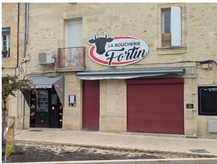
Exemple d'enseigne non conforme rue Nationale
