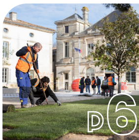
DANS VOTRE QUOTIDIEN Les travaux dans votre ville
