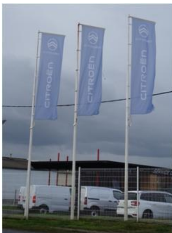
Hauteur non conforme
